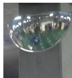
( Ha colocado un espejo en la columna fuera del ascensor, para que pueda ver desde el interior la situación del exterior)
